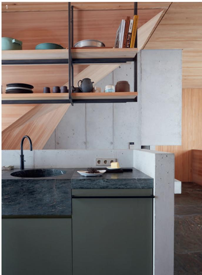
**1**\_Ein Kern aus Beton, in dem sich auch der Kamin befindet, stützt den Holzbau zusätzlich. In der Küche bricht er aus und formt einen der Küchenblöcke. Das Becken ist aus Quarzit gefertigt.
